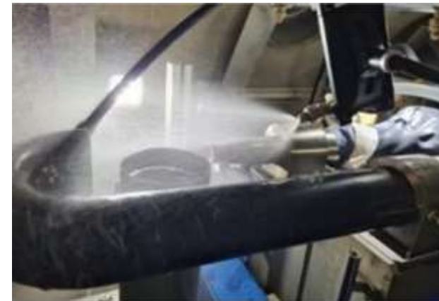
高圧水除染の例
