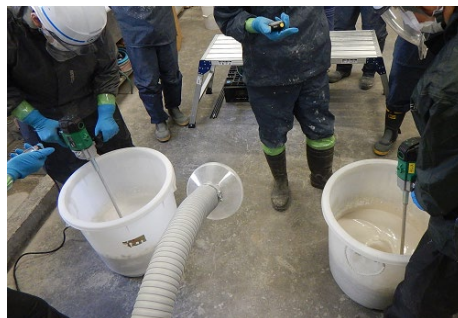
ミキサーで混練(90s→30s掻き落とし→90s)。 2班体制で、打設している間にもう一方が混練。
