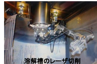
溶解槽のレーザー切削
