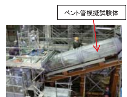
図2 ベント管止水用止水材試験状況
